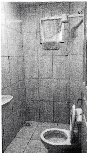
Foto 11: Banheiro 1º piso
