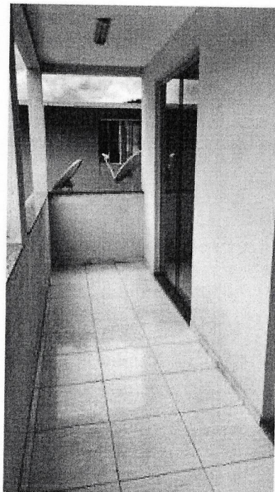
Foto 22: Sacada do 2º piso
