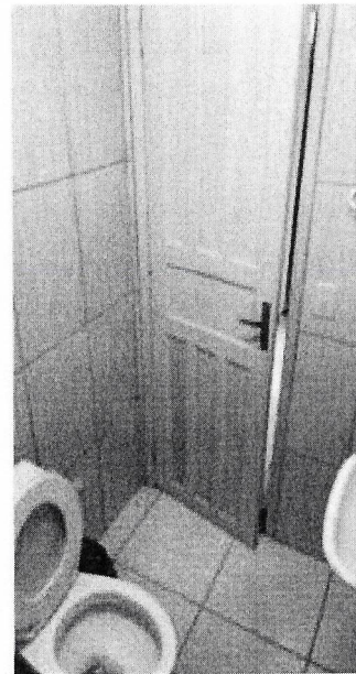
Foto 12: Banheiro 1º piso
